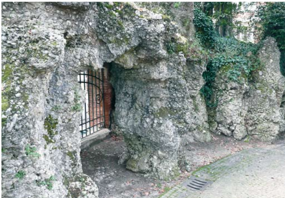
Udine, Giardini Ricasoli, presso Porta Manin. Parte dell'antico livello di conglomerati pleistocenici inarcato dall'ampia piega affiora nel centro cittadino. Osservando con cura l'affioramento si notano frequenti strutture sedimentarie sicuramente non antropiche.
